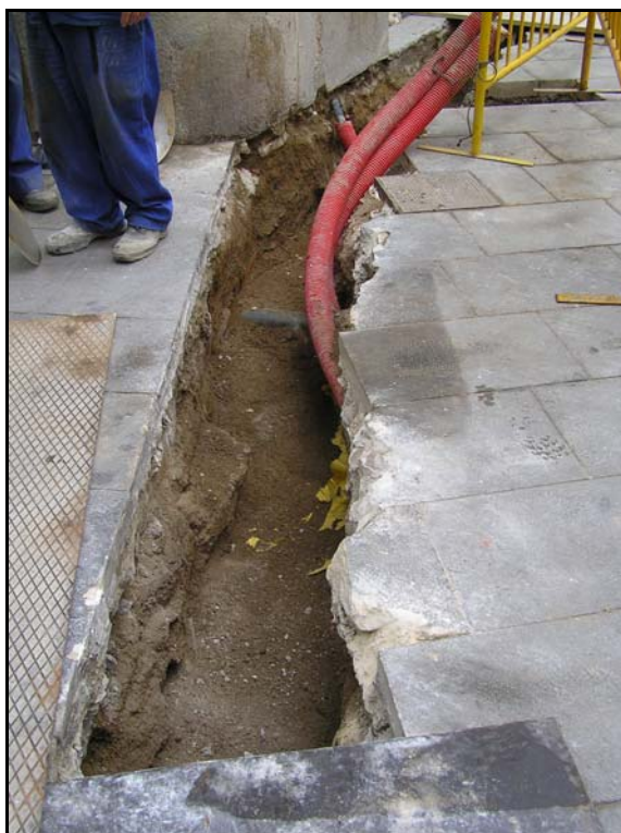
Foto 4: Rasa en la intersecció amb el C/Ataülf.
